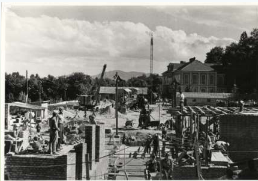
Gradbišče – hala Tivoli
